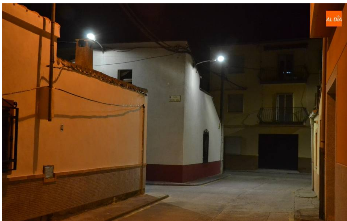
Nuevas luminarias instaladas recientemente en Ciudad Rodrigo con fondos municipales
