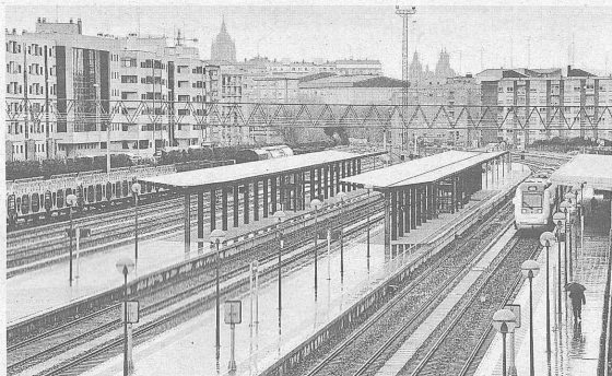
La inversión económica de la UE permitirá concluir la conexión entre Fuentes de Oñoro y Medina. | ARCHIVO
