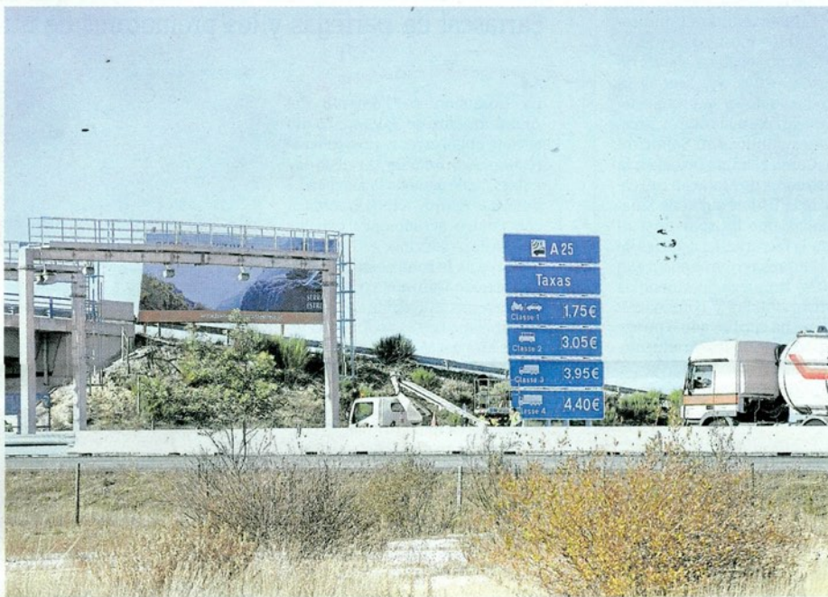
Primer arco de peaje en la A-25 tras pasar la localidad fronteriza de Vilar Formoso./CASAMAR
