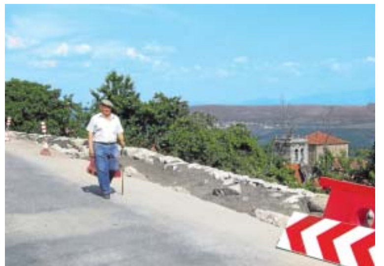
El Ayuntamiento acondicionará la margen izquierda de la travesía. /CASAMAR
