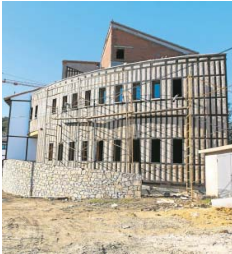
Obras de la segunda fase de la residencia de mayores./CASAMAR
