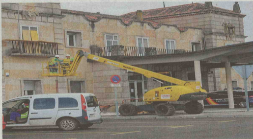
Los operarios realizan las tareas para la retirada de los escudos en el edificio de la Policía. | FOTOS: CASAMAR
