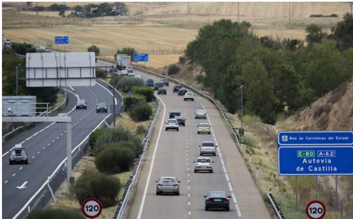
Imagen de la A-62, donde se invertirán 1,5 millones para su restauración. / EL NORTE
