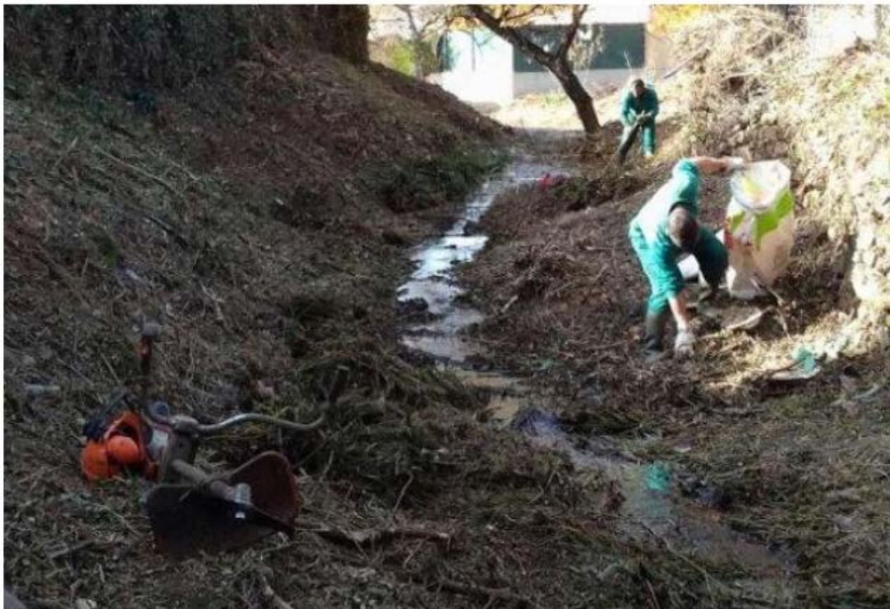
Dos operarios trabajan en un cauce en Sareadilla del Arroyo. / WORD
